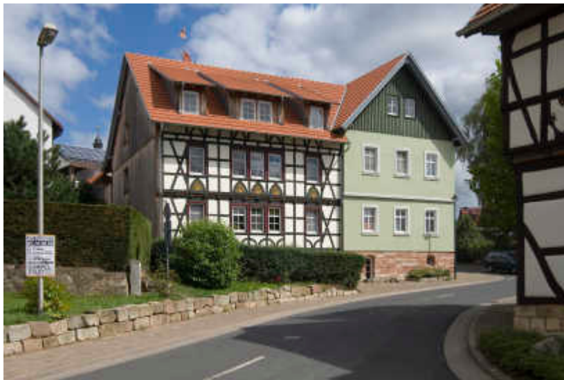
Mit der Sanierung der ehemaligen Schule wurde Wohnraum für junge Familien in Möhra geschaffen. Foto: Falko Behr
